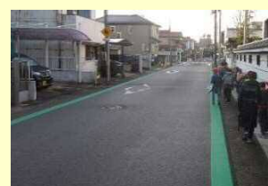
【路肩カラー舗装】
