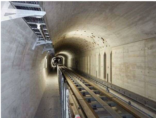
シールド工法
