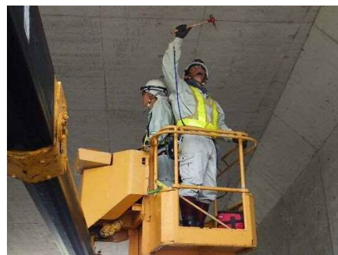
点検用ハンマーによる打音検査
