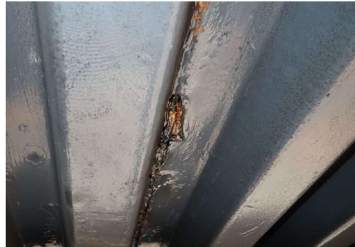
床板の腐食
