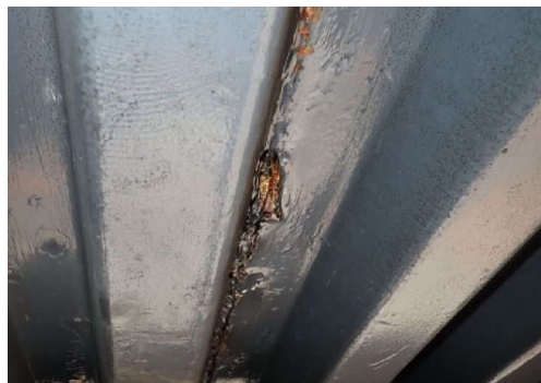
床板の腐食
