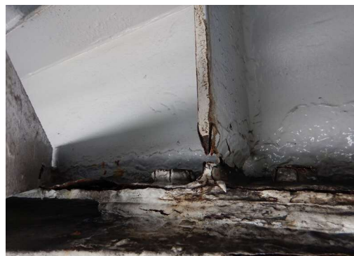
横桁部の腐食
