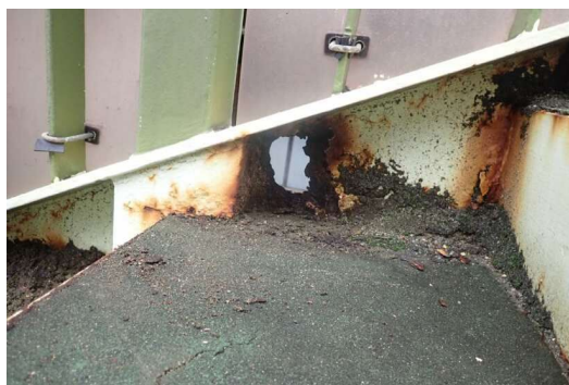
階段部主桁の腐食
