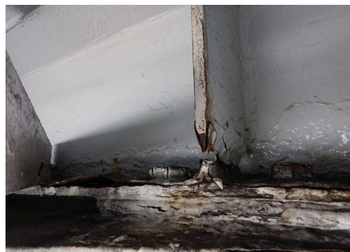
横桁部の腐食
