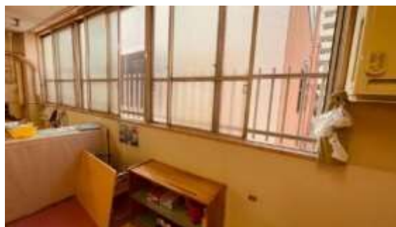
1歳児クラス窓 （床高980mm＋柵660mm、すきま90mm）
