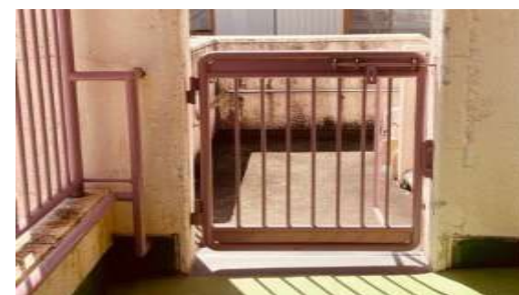
屋外階段侵入防止柵 （床高1120mm、すきま100mm）
