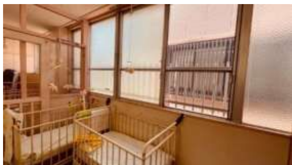
0歳児クラス窓 （床高980mm＋柵660mm、すきま90mm）
