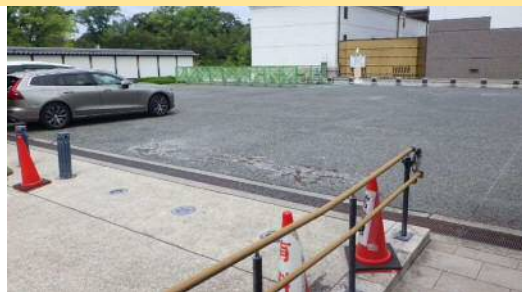
透水性コンクリート舗装
