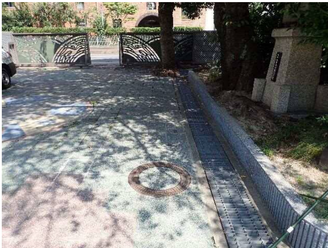
防火水槽蓋の位置
