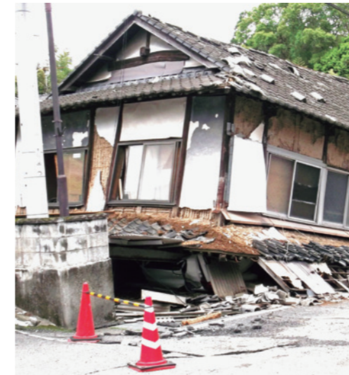
木造住宅倒壊の様子 Collapse of a wood-frame house
