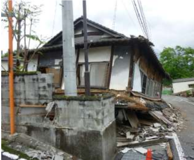
1 階部分がつぶれた全壊家屋の様子（熊本県上益城郡益城町）
