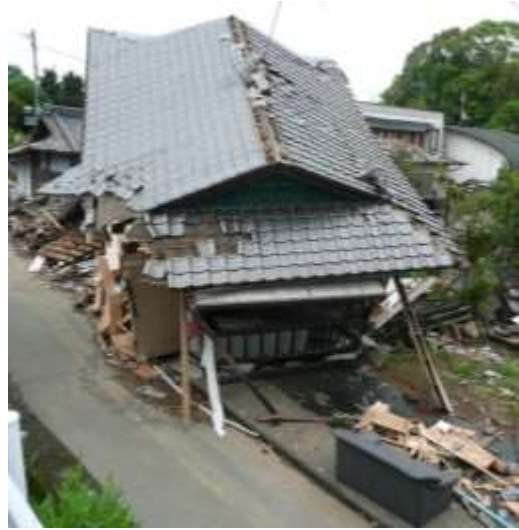
1 階部分がつぶれた全壊家屋の様子（熊本県上益城郡益城町）
