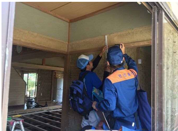
○建物被害認定調査の支援状況（7月18日（水））
