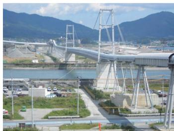
かさ上げ工事を加速させた土砂運搬用の巨大ベルトコンベア「希望のかけ橋」
