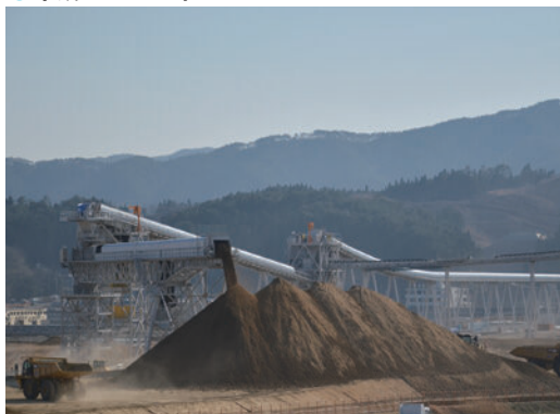
かさ上げされる市街地 (土砂運搬を加速させた巨大ベルトコンベア)
