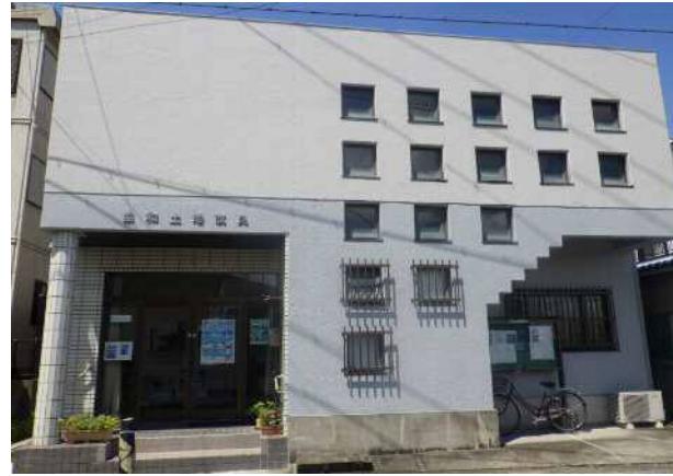
協和土地改良区事務所
