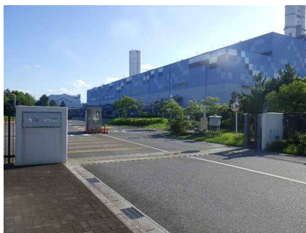
(株)JERA O&M本部新名古屋火力発電所 (収容人員110人)
