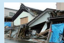
住宅被害の一例
