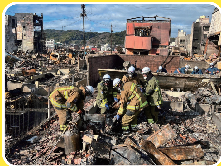
令和6年能登半島地震による火災（石川県輪島市「朝市通り」令和6年1月撮影）
