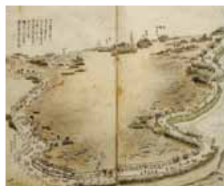
【決壊した堤防の様子】
