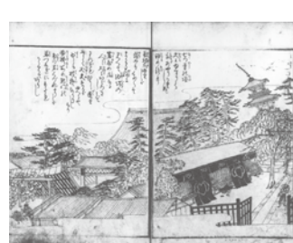
【七寺(中区大須地区)の被害の様子】
