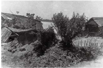
手越川車路橋付近の決壊現場では、住家が流されている様子が分かります。
