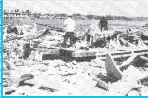
写真② 伊勢湾台風で倒壊した日本毛織工場
