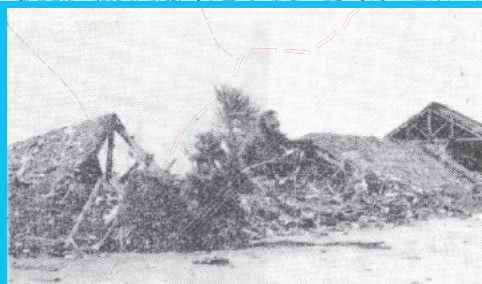
写真⑦ 伊勢湾台風で倒壊した大森小学校南側校舎
