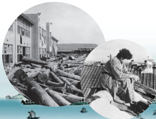
水がひかず、屋根の上で途方にくれる人
