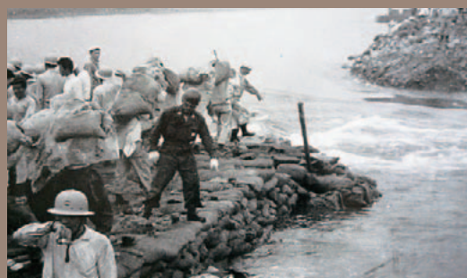
山崎川仮締切工事 (愛知県 提供)
