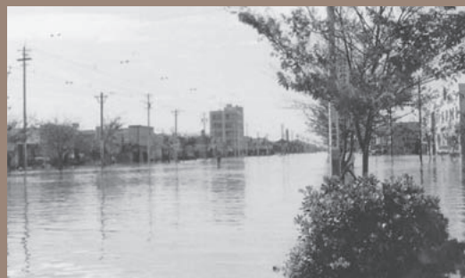
伊勢湾台風翌日の空港線 (瑞穂土木事務所 提供)
