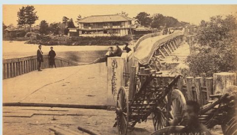
枇杷島橋崩壊(名古屋博物館提供)
