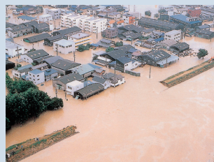
新川決壊箇所
