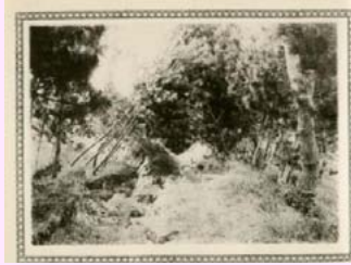
安井村庄内川堤防大崩
