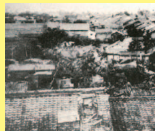
名古屋市清水町震害
