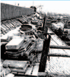
建中寺本堂 大棟修復 写真提供:建中寺
