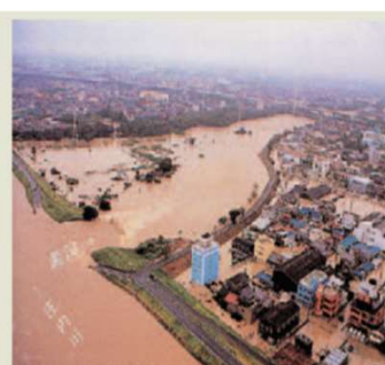
東海豪雨の際の洗堰の様子
