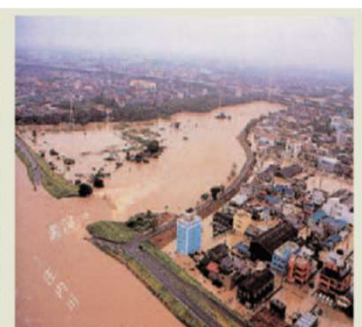
東海豪雨の際の洗堰の様子
