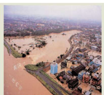
東海豪雨の際の洗堰の様子
