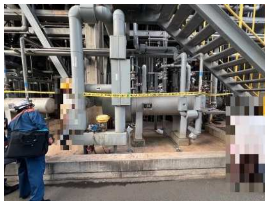
↑ 製造所に設置されている熱交換器
