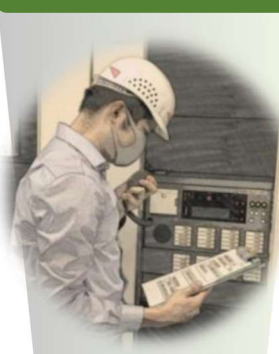
① 非常放送設備
