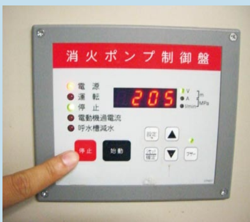
⑤ポンプ制御盤（ポンプ室等）の停止操作を行う
