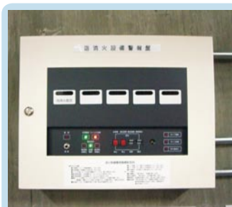
⑥警報盤（ポンプ室）の復旧操作を行う
