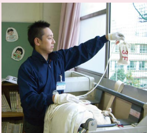
① キャビネットを取り除き、バンドをはずし砂袋と誘導綱を投下する
