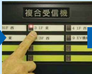
②受信機のランプが点灯している表示窓を確認する
