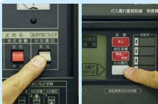
④復旧スイッチを操作する
