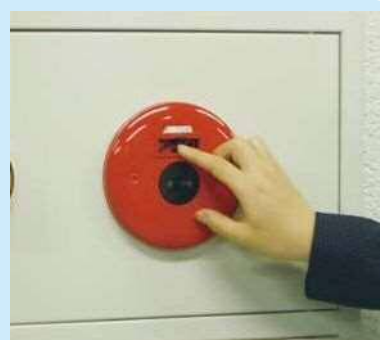
③発信機のボタンを復旧する (復旧方法は、ボタンを引き戻すタイプと小窓内の復旧スイッチを押すタイプがあります)
