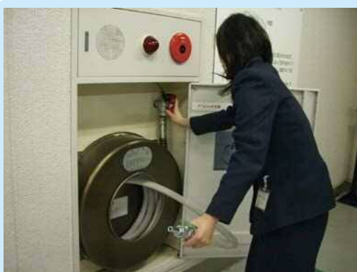
① ノズルのバルブを閉めた後 開閉バルブを閉める (時計回り：右回転)
