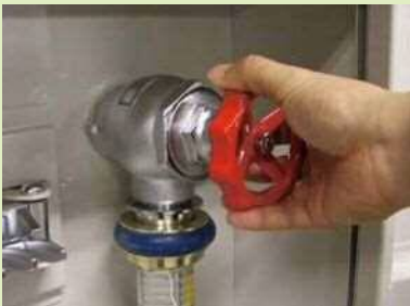
⑤ ノズル係員の合図で開閉バルブを開ける（反時計回り：左回転）
