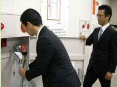
① 消火栓ボックスを開け、ノズルとホースを外す（1人がノズル、1人がバルブ操作）
