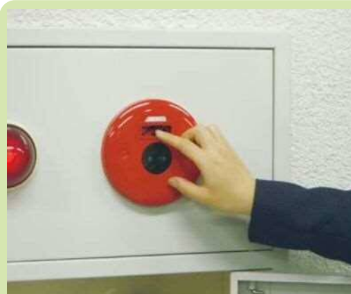
② 起動ボタンを復旧する(復旧方法は、 ボタンを引き戻すタイプと小窓の中の 復旧スイッチを押すタイプがあります)
