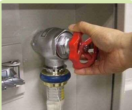
① 開閉バルブを閉める (時計回り：右回転)
