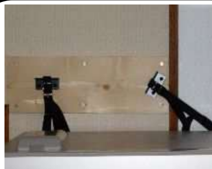
家具転倒防止ボランティア による施工状況
