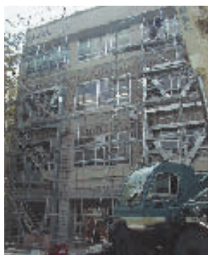
避難所(学校等)の耐震改修
