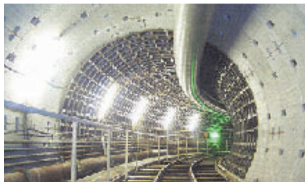
建設中の名駅南雨水調整池
