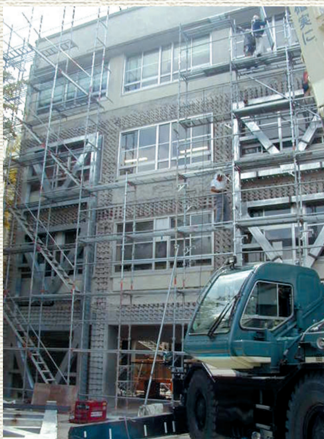
避難所(学校等)の耐震改修
