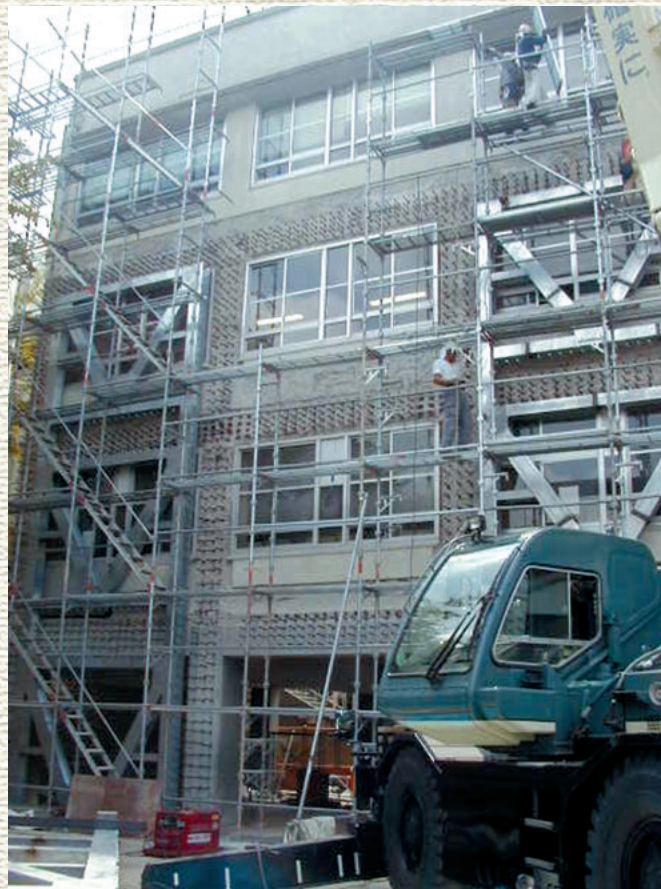
避難所（学校等）の耐震改修
