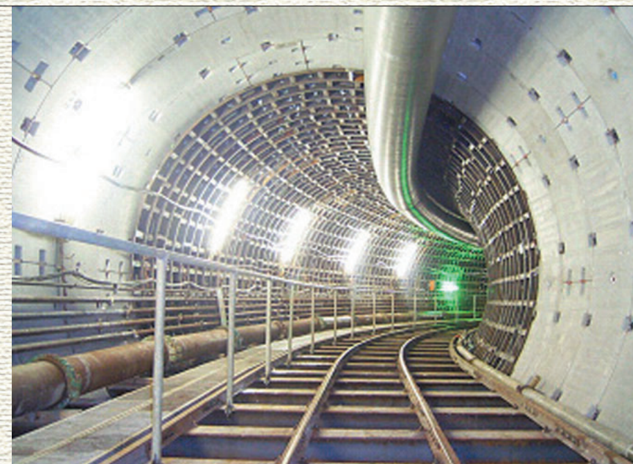
建設中の名駅南雨水調整池
