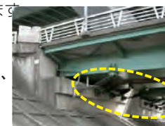
橋りょうの耐震補強の例
