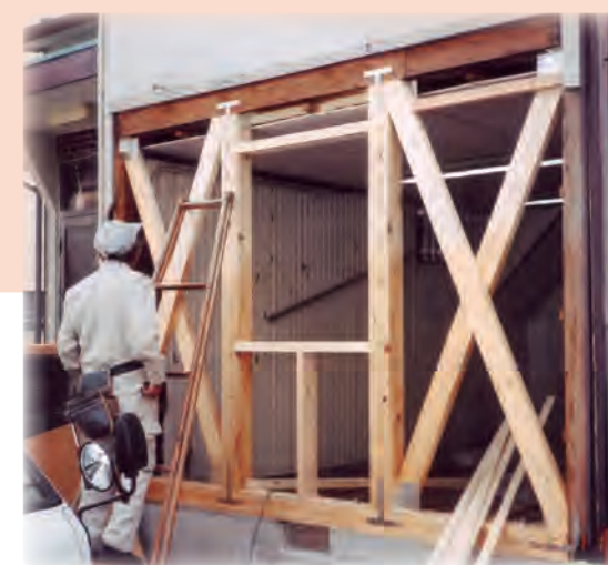
住宅の耐震改修
