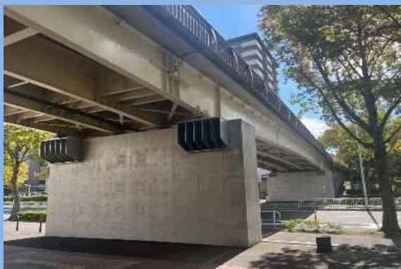
◆写真1 橋りょうの耐震化（三本松橋）
