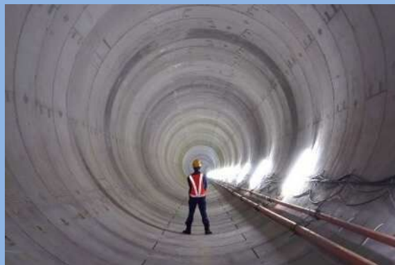
◆写真2 名古屋中央雨水調整池
