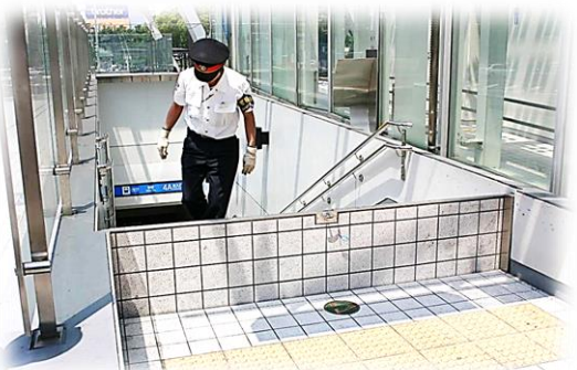
地下鉄の止水板 (立ち上げ方式)
