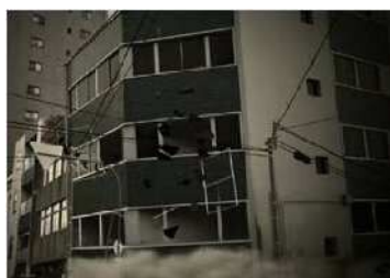
〈強い揺れによる建物崩壊〉
