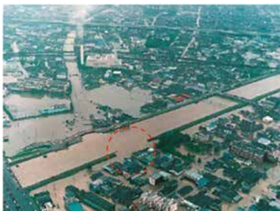
新川左岸破堤箇所（名古屋市西区）
