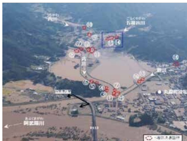
堤防決壊（18箇所）により浸水した 宮城県丸森町役場周辺
