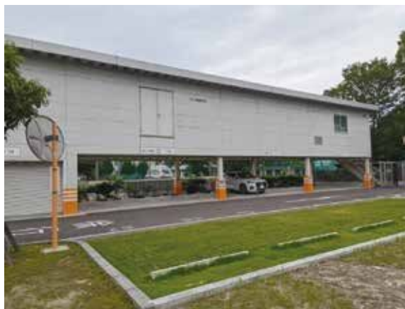
浸水に対応した倉庫（西区役所山田支所）
