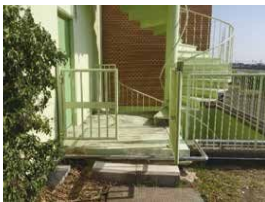
津波避難ビルの屋外階段（蟹江川排水機場）
