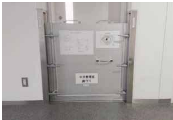
止水版の設置 (東雲合同庁舎 (東京都))
