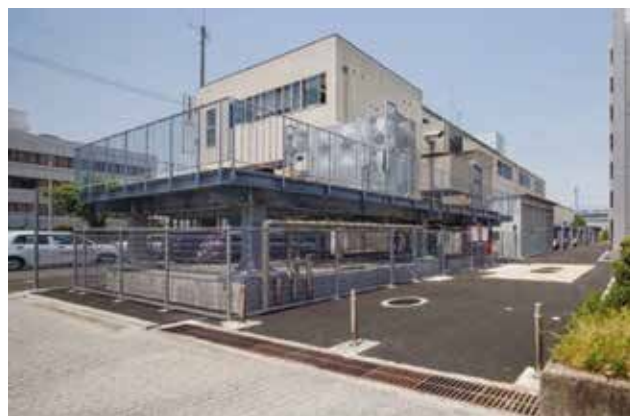
非常用発電機と受水槽を屋外の架台上に移設 (広島港湾合同庁舎 (広島県))
