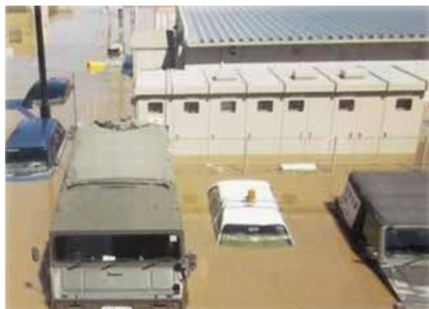
浸水した非常用発電機
