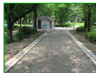
↑ 園路と広場の段差解消
