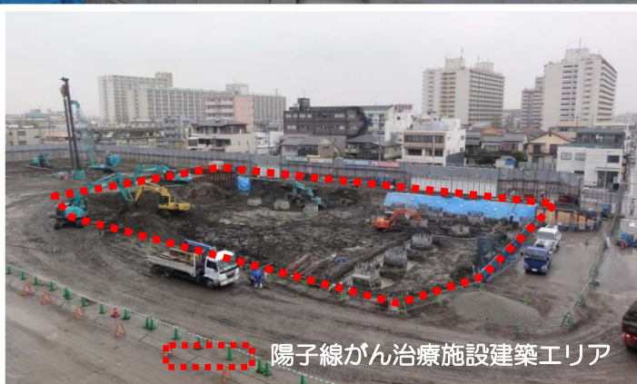
写真上 陽子線がん治療施設工事状況（H22年4月）
