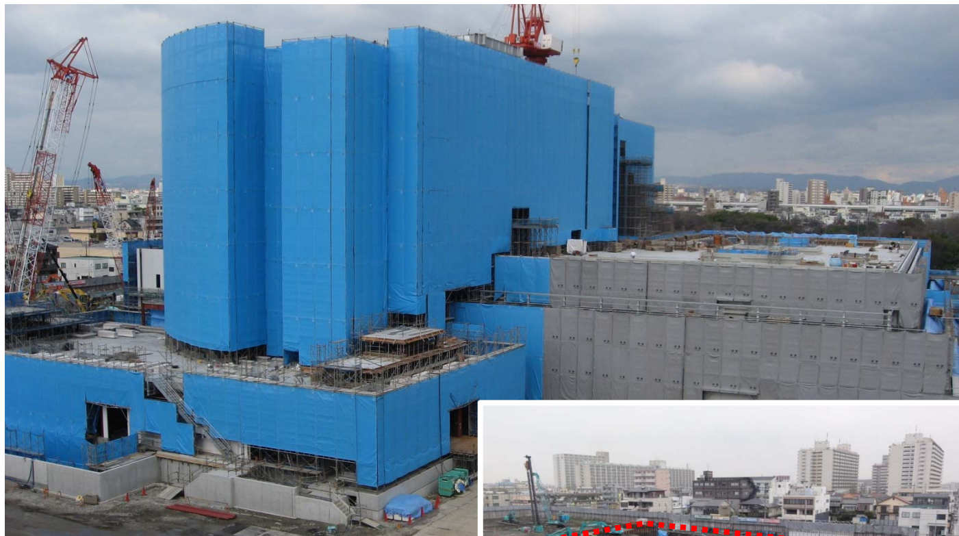
写真上 西部医療センター中央病院（仮称）工事状況
