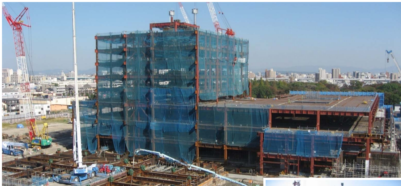
写真上 クオリティライフ 21 城北敷地内工事状況 (H.21.11.6)
