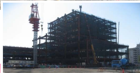
写真右 地上から見た病院工事状況
